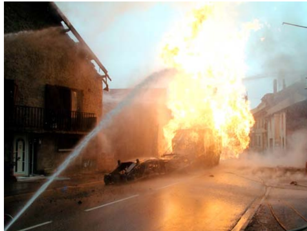
Incendie suite à l'endommagement d'une canalisation de distribution de gaz par une raboteuse de chaussée
