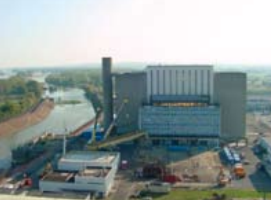
Photo EDF Travaux de déconstruction des anciens réacteurs de Chinon
