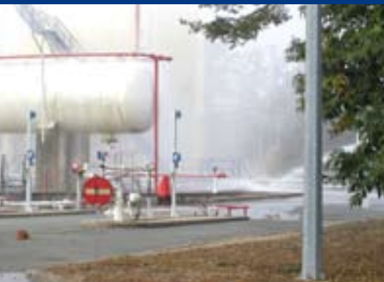
L'usine Primagaz dispose d'un CLIC.
