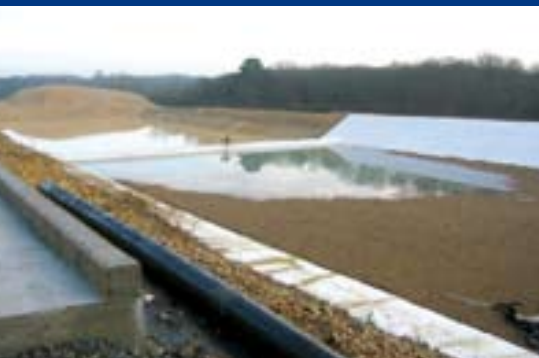
CSDU de Villeherviers, alvéole en attente de mise en exploitation.
