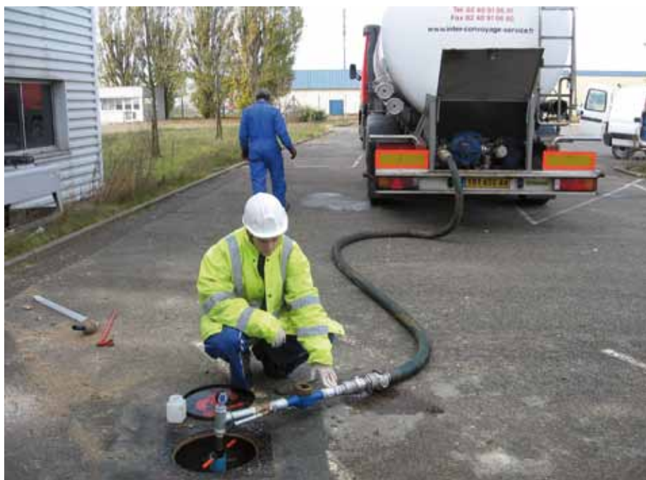
Injection d'une solution d'hydrates de carbone en vue de créer un réacteur biologique anaérobie in-situ (bioprécipitation du chrome et réduction des solvants chlorés) - Photo Perfect Circle.
