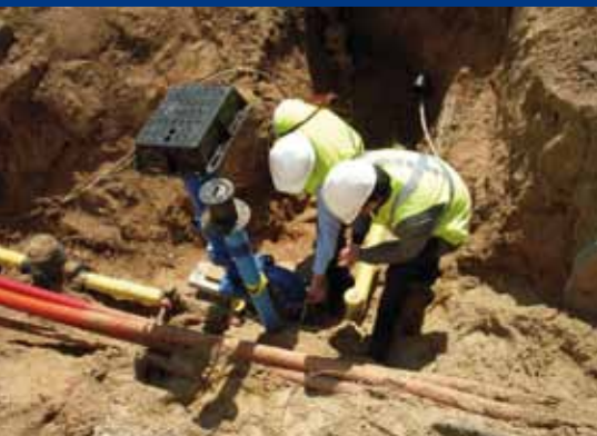
Deux inspecteurs de la DRIRE contrôlent des canalisations sur un chantier public.
