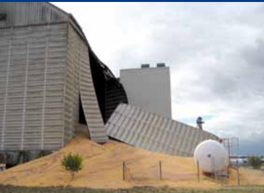
Accident d'un silo à Saint-Hilaire-sur-Puiseaux le 19 août 2008.
